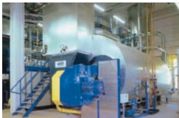
Паровой котел высокого давления UNIVERSAL UL-SX с пароперегревателем
