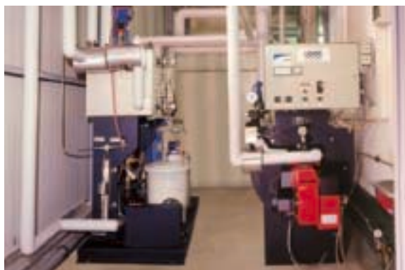
Котел Dampfix DF с деаэрационным модулем WSM-T
